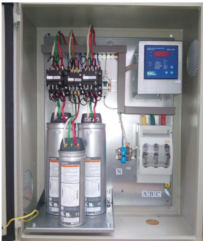
Рис. – Установка компенсации реактивной мощности УКРМ
